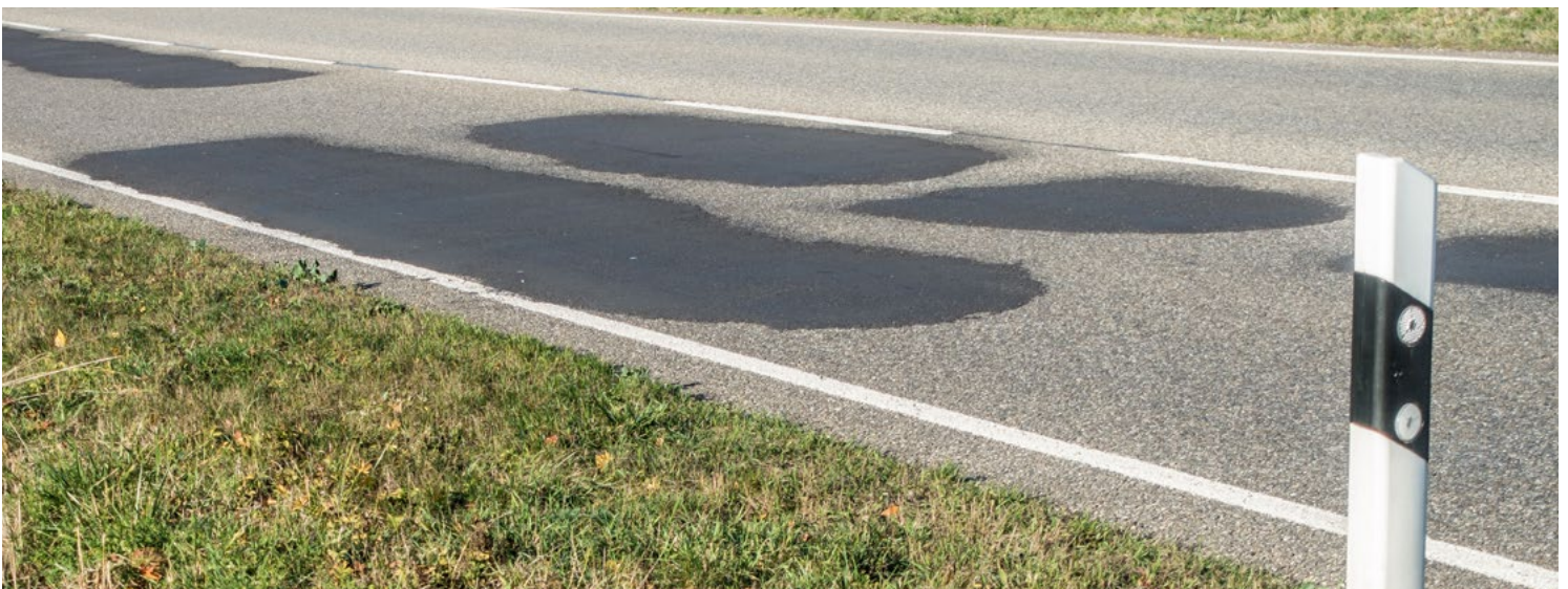
Nach der Sanierung mit dem Polymerasphalt austropox® GK4
