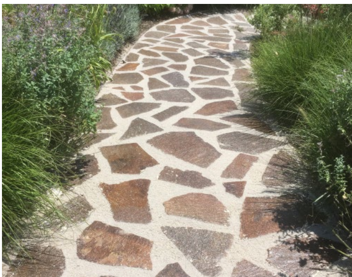
Spárování desek z přírodního kamene
