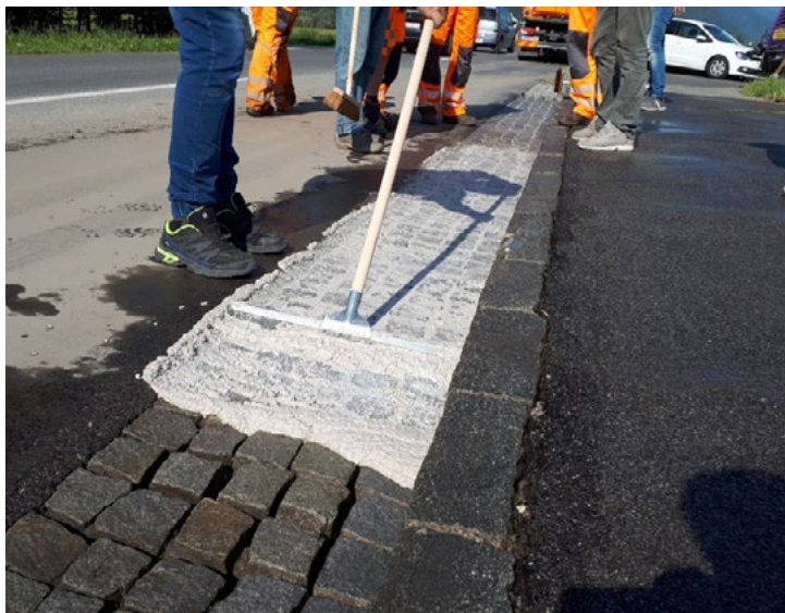
Zakalení austropox® spár z reaktivní pryskyřice
