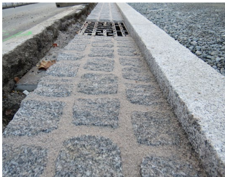
Spárování odvodňovacích žlabů a struh
