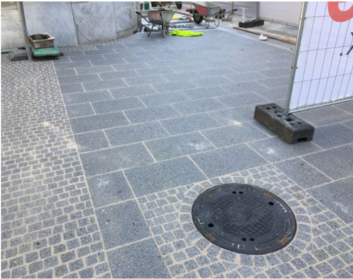
Spárování dlažeb ve městech
