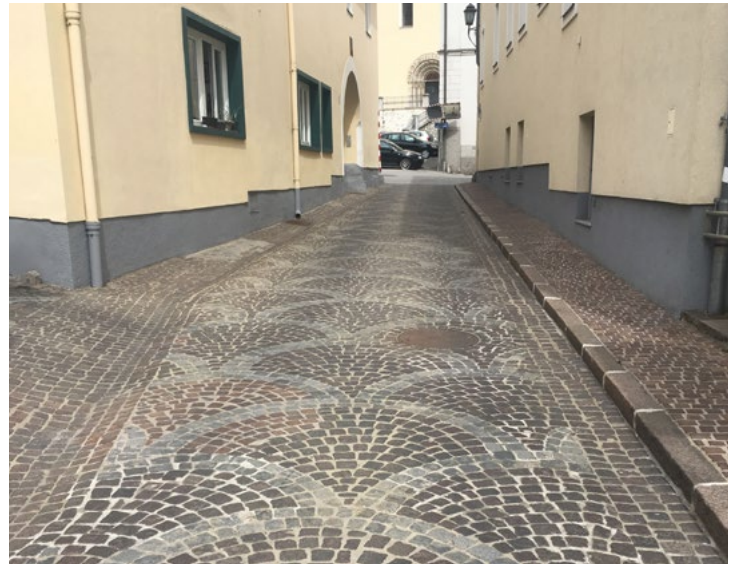
Novostavby a sanace dlažeb
