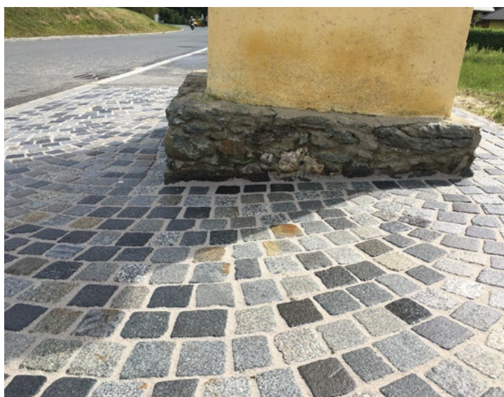
Vzhled spáry po sanaci
