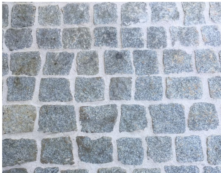
Mozaiková plocha po vyspárování systémem austropox®
