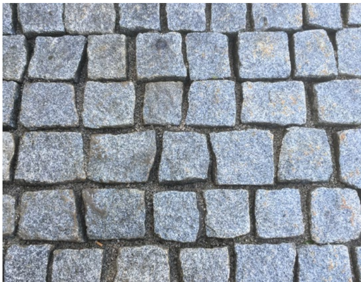
Mozaiková plocha po čištění, před spárováním
