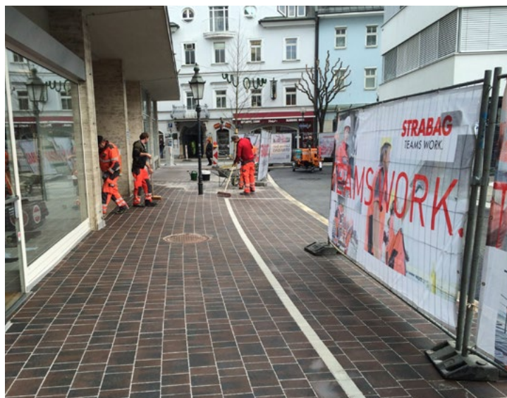
Uzavírání spár odolné proti zametacím strojům v centru měst
