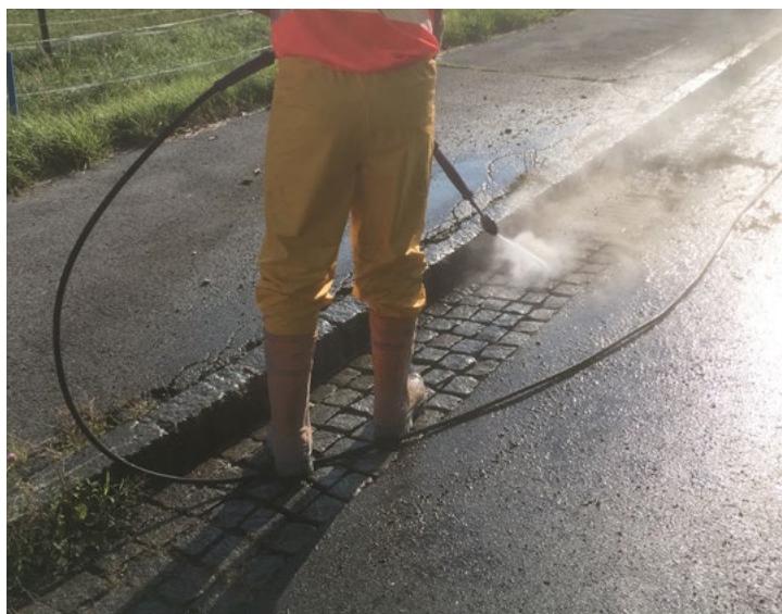
Čištění plochy pomocí VTV nebo tlakového vzduchu
