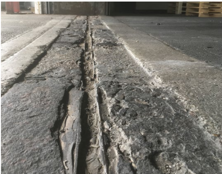
Vor der Sanierung
