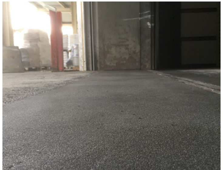
Nach der Sanierung mit austropox® SR1
