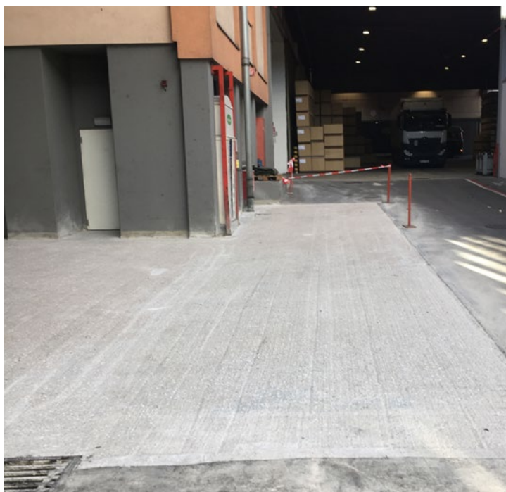
Frézovaný, připravený podklad
