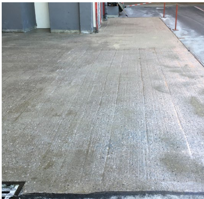
Plocha po natření primerem austropox® SRX
