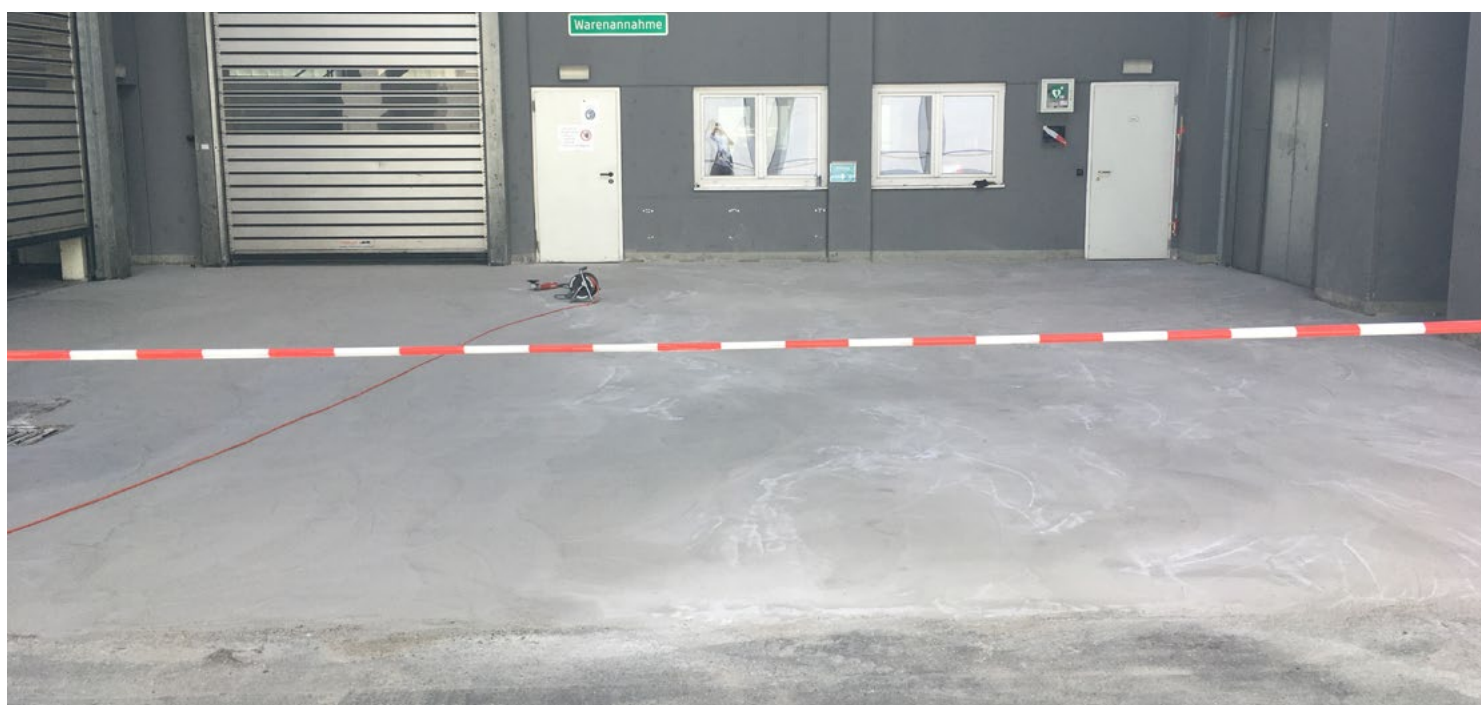
Betonový povlak s betonem austropox® SR8 před broušením povrchu
