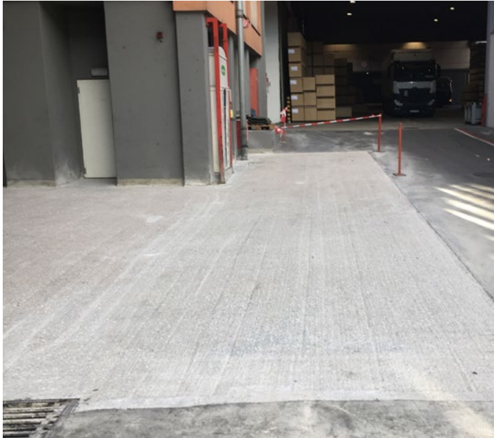
Gefräster, vorbereiteter Untergrund
