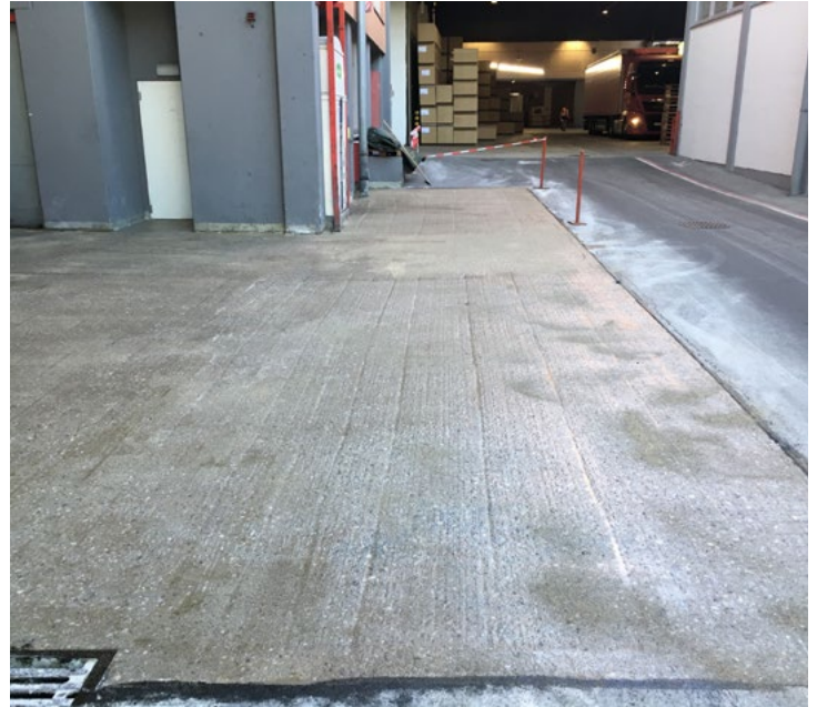
Fläche nach Grundiervorgang mit austropox® SRX-Primer
