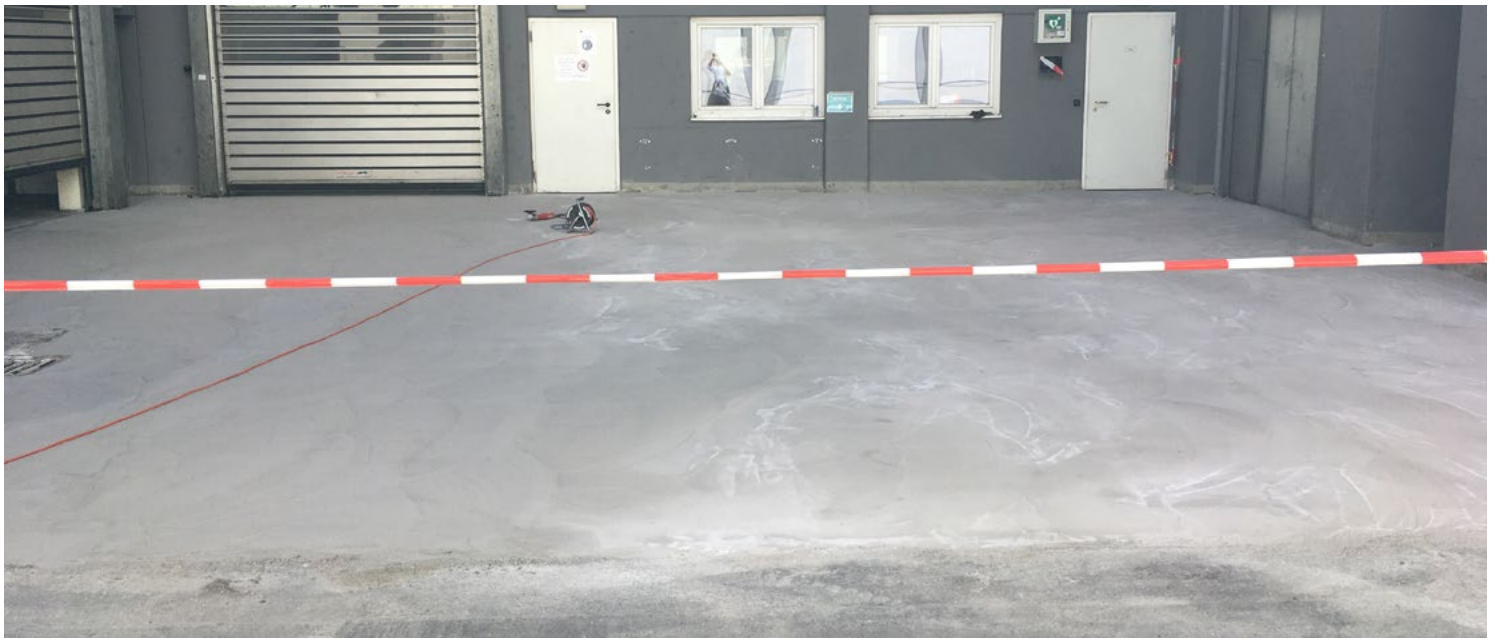
Betonüberzug mit austropox® SR8 vor dem Planschleifen
