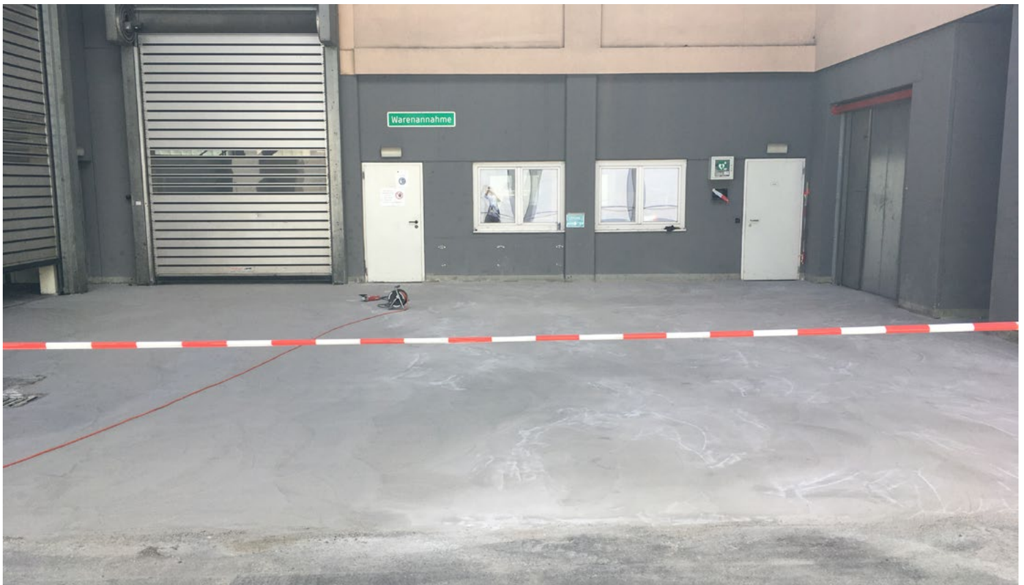
Náter betónu s austropox® SR8 pred brúsením povrchu
