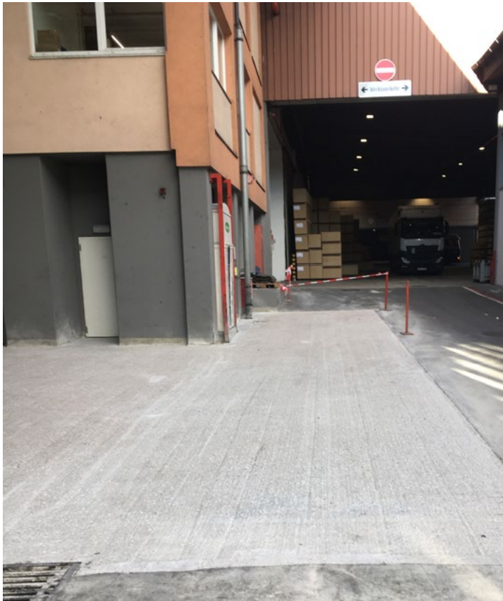
Frézovaný, pripravený podklad
